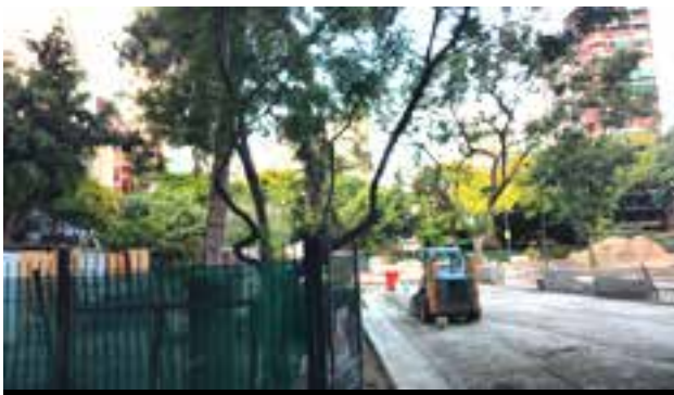
Trabajos de remodelación en la Plaza Noruega.
