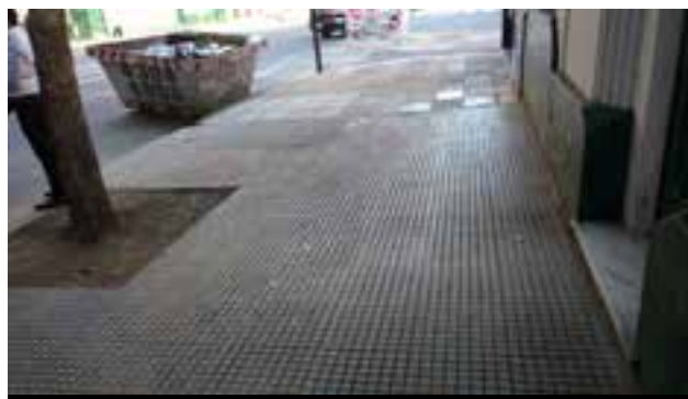
Vereda reparada en Cramer al 2500.
