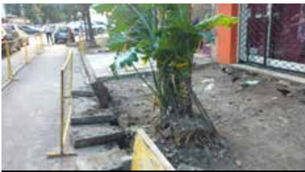
Vereda en reparación en Juramento y Crámer.
