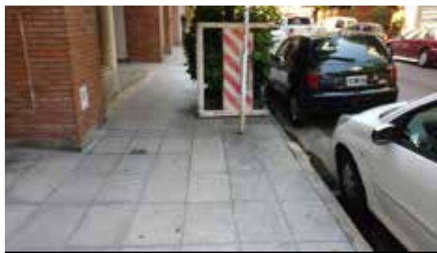
Vereda reparada en Amenábar al 2800.
