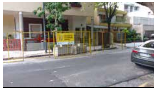
Vereda en reparación en Núñez y Vidal.
